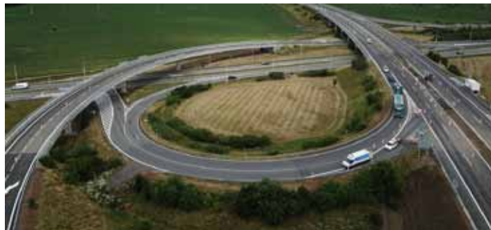
Z výšky. Nová část obchvatu byla otevřena na konci června. Foto: ŘSD Zlín
